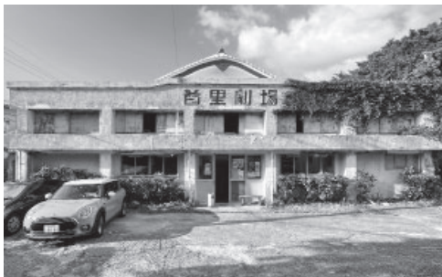
（写真1）解体直前の首里劇場。2023年10月13日 （著者撮影）
